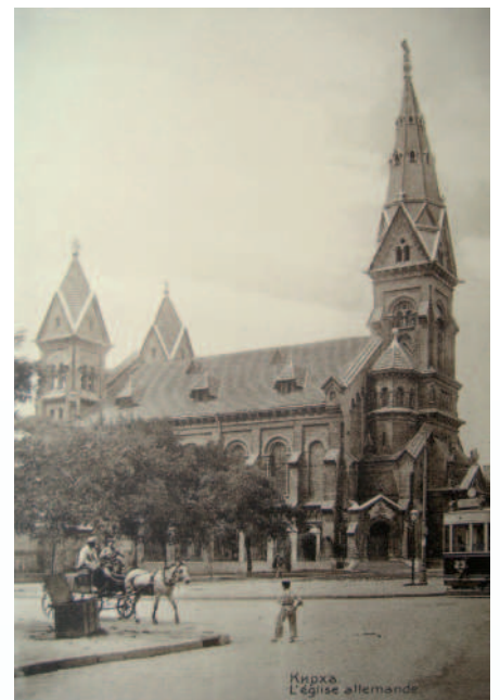
Evangelisch-lutherische Kirche in der Stadt Odessa, erbaut 1896/97. Das Kirchengebäude bot Platz für 1 200 Gottesdienstbesucher und galt lange Zeit als das höchste Gebäude der Stadt.
